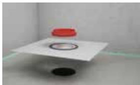
In questo passaggio è possibile installare il kit di impermeabilizzazione direttamente nel corpo di scarico senza utilizzare attrezzi, innesto diretto.
