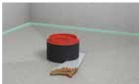
Questo passaggio è molto semplice perchè: il massetto è già stato completato, comprese le pendenze, ma senza preoccuparsi dell'altezza. Non è necessario posizionare lo scarico alla stessa altezza del massetto come un comune corpo di scarico poichè rimane sempre una parte in eccedenza che si può tagliare con una sega o con un flessibile appena il massetto si è asciugato.
